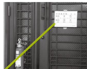
状況表示板を貼付した玄関
